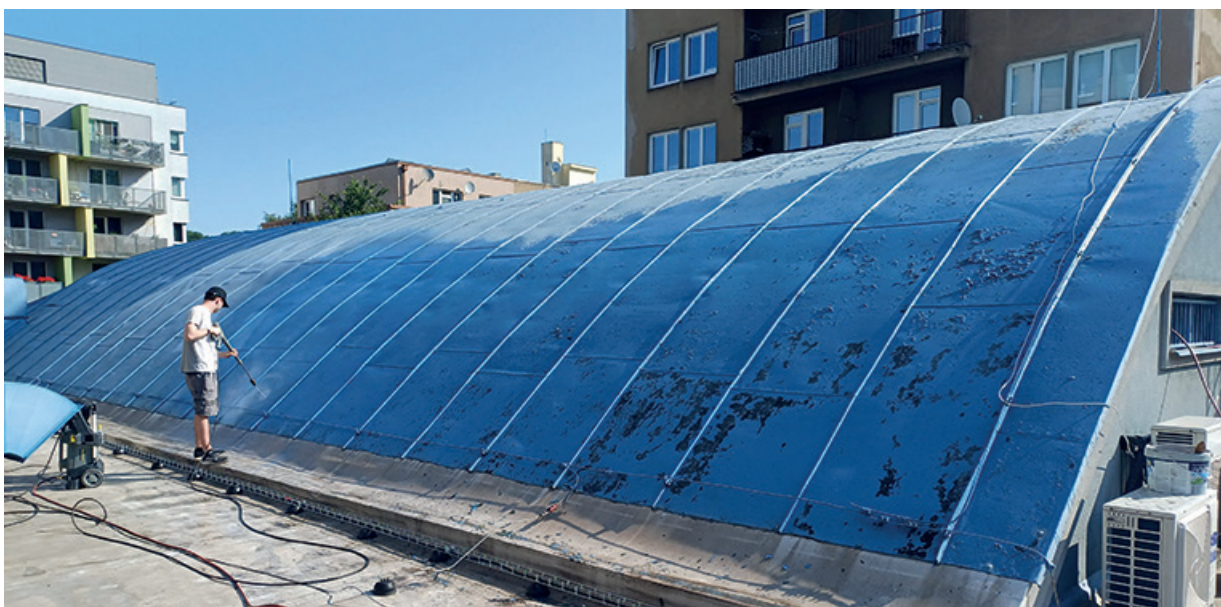
Oprava střechy Divadla Gong
