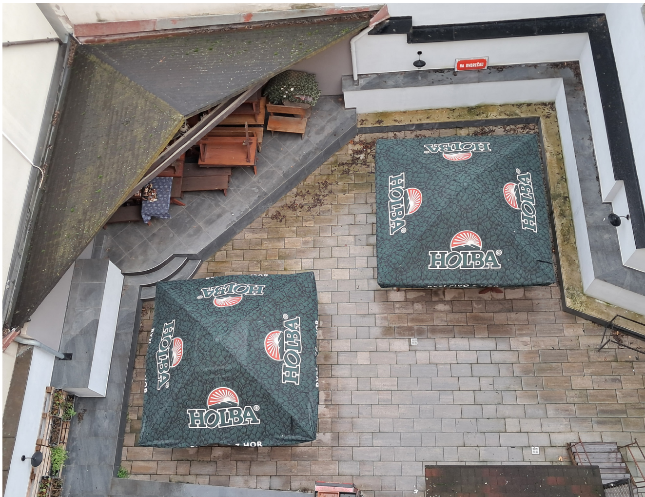
Oprava vnitrobloku Obecního domu, tzv. „Dvorečku“.
