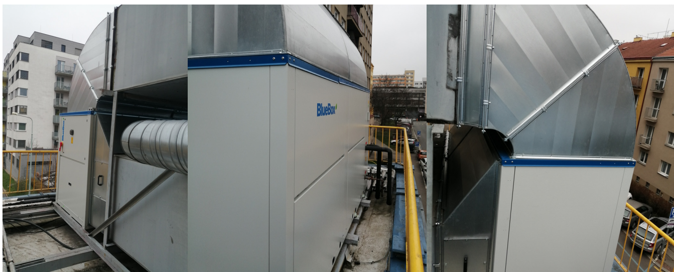
Nová klimatizační jednotka byla na střechu Divadla Gong nainstalována v prosinci 2023
