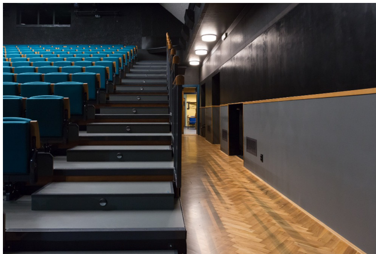
Nové ostění Velkého sálu z křemíkových panelů
